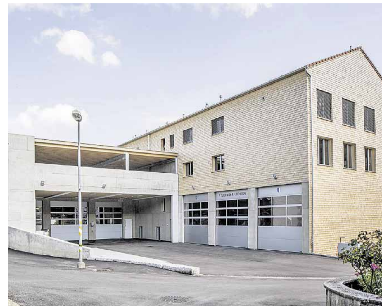
Das Feuerwehrmagazin und der Werkhof im Hinterhof.
